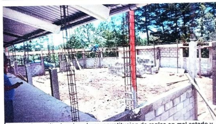
Foto 4: la sustitucion de galeras y sustitucion de reglas en mal estado y a hora el avance de colocación de columnas de fundición de concreto.
