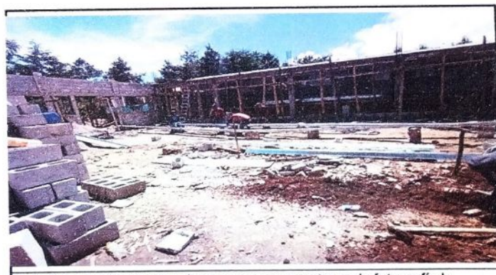
Foto 6: La sustitucion de galeras como se muestra en la fotografia la instalación de columnas concretado y la sustitucion de reglas por costaneras
