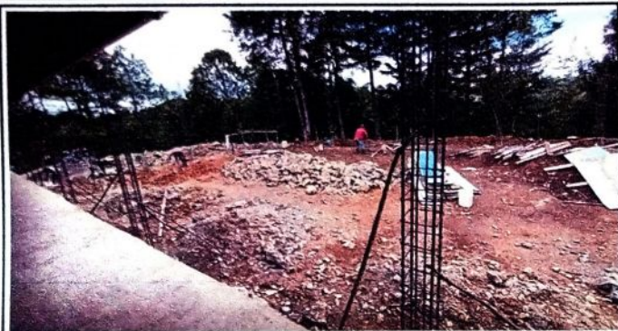
Foto1: Con el apoyo de padres de familais se hizo las bases del proyecto de remozamiento. Se evidencia el inicio del mantenimiento de la escuela Oficial Rural Mixta Comunidad San Antonio I. La medida de 18 metros de
